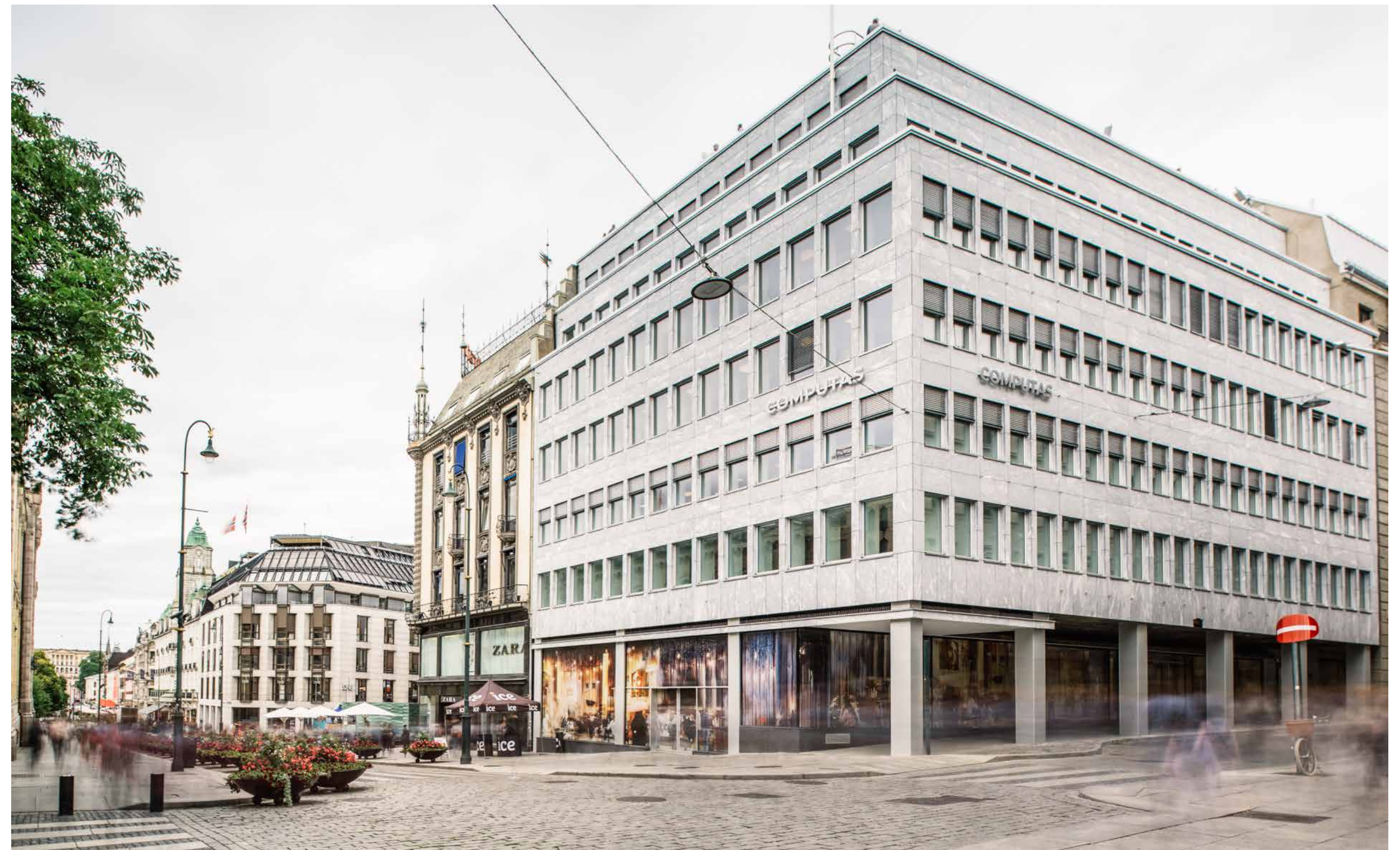
Akersgata 35–39, Oslo. | Foto: Malling.
