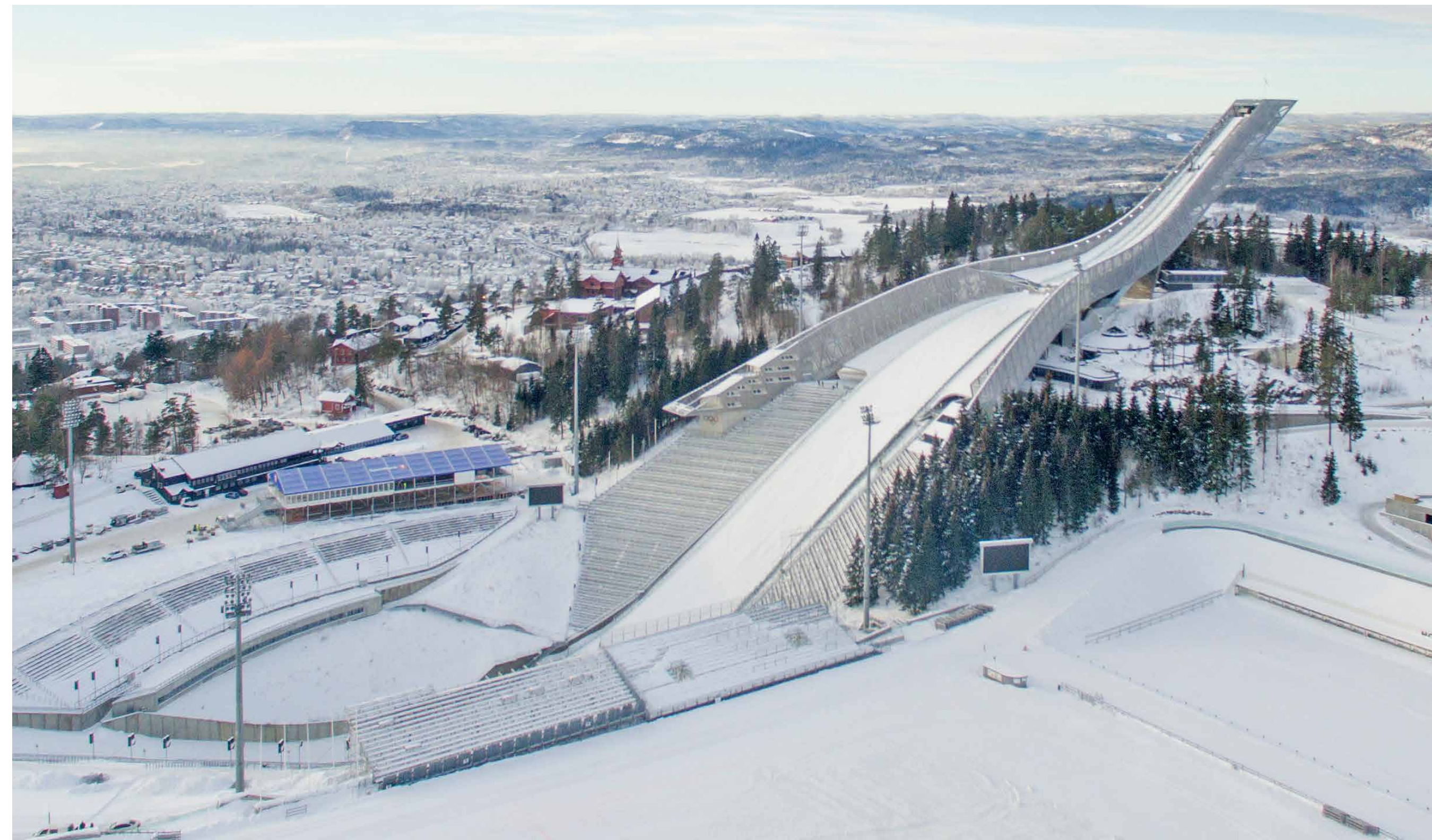
Holmenkollbakken er en hoppbakke som er en del av Holmenkollen nasjonalanlegg. Bakken er et landemerke i Oslo og et av Norges mest besøkte turistattraksjoner. Anlegget er forsikret i Oslo Forsikring. | Foto: stock.adobe.com
