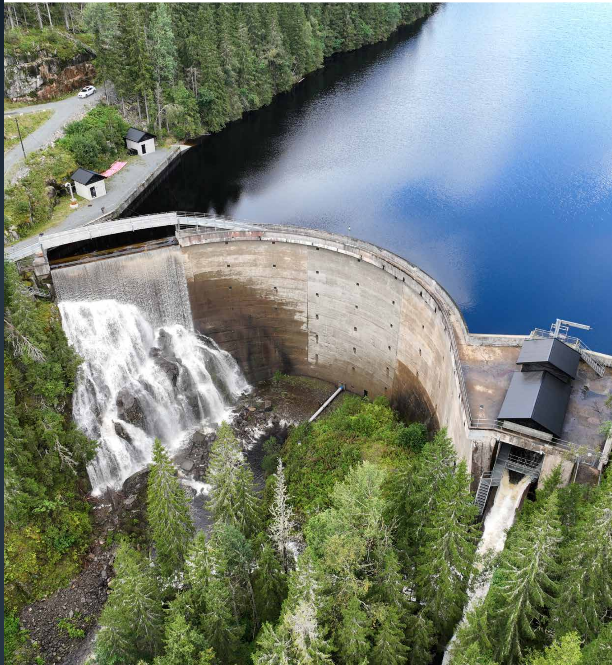
OF bruker dronefilm og dronefoto som et ledd i oppfølging og forebygging av skader. Her fra demningen i Langlivann, som er et langstrakt, oppdemmet vann som danner skillet mellom Nordmarka og Krokskogen. Foto: Ulrik Løvstad Engmann / Oslo Forsikring
